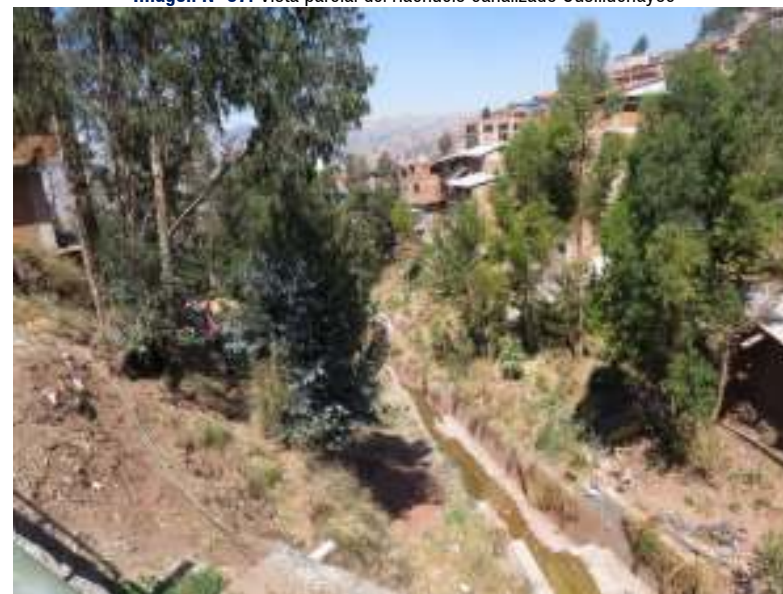
Imagen N° 37: Vista parcial del riachuelo canalizado Cusilluchayoc
