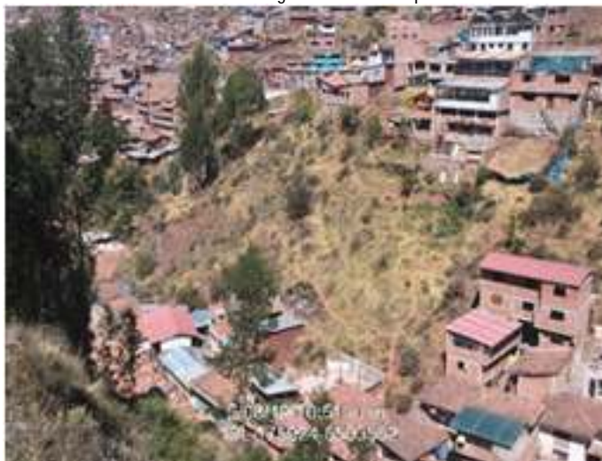
Imagen N° 16: Manifestaciones de deslizamientos que representan zonas de peligro muy alto en la ZRECU09 margen derecha de la quebrada.
