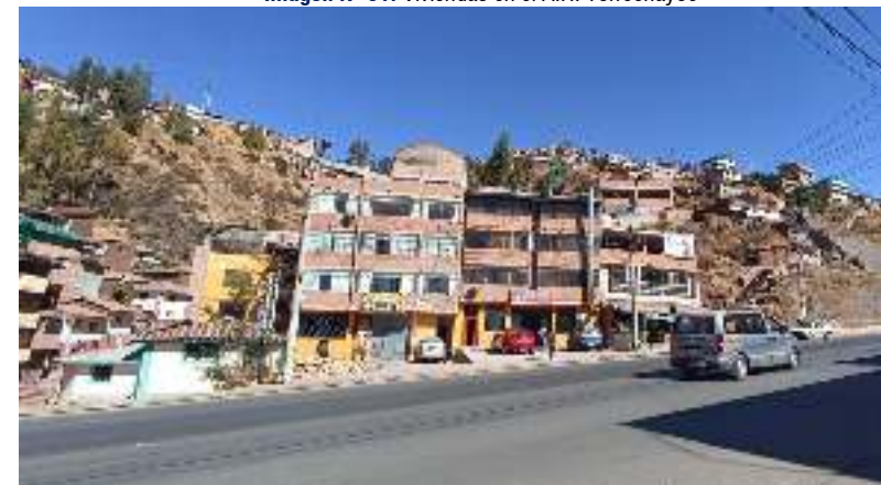
Imagen N° 61: Viviendas en el A.H. Torrechayoc
