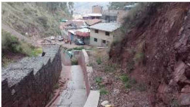
Imagen N° 5: Vista de Tendido del cable sísmico y ubicación del equipo GEODE para la LS-02-03
