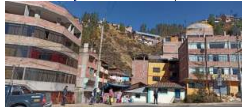
Imagen N° 60: Viviendas en el A.H. Torrechayoc
