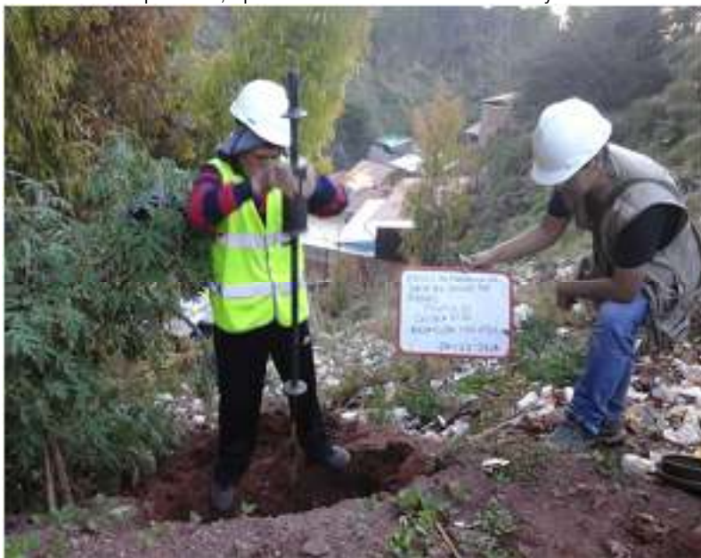
Imagen N° 4: Vista de la realización de sondajes con el cono de penetración ligera (PDL) en las calicatas aperturadas, a partir del cual se obtuvieron datos físicos y mecánicos
