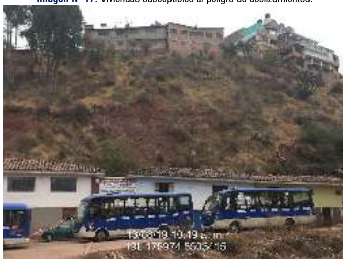
Imagen N° 17: Viviendas susceptibles al peligro de deslizamientos.
