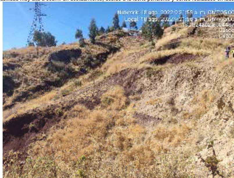
Imagen N° 19: Áreas con probabilidad muy alta a ocurrir un deslizamiento, debido a la fuerte pendiente y cortes realizados en ladera, sector noreste de la ZRECU06.
