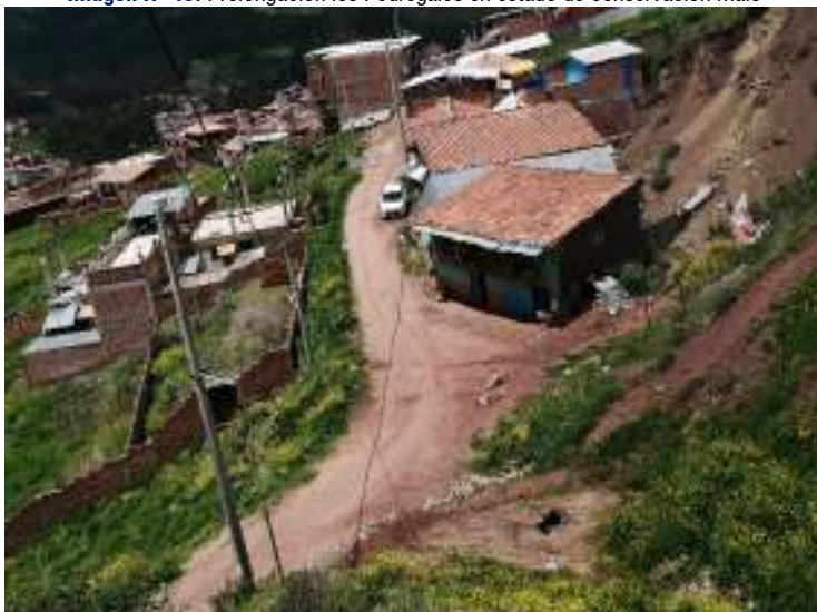
Imagen N° 45: Prolongación los Pedregales en estado de conservación malo
