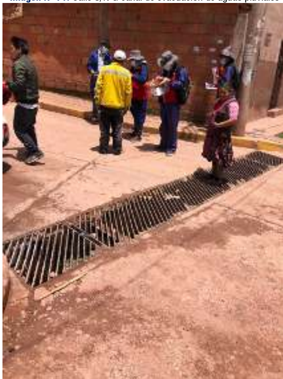
Imagen N° 71: Calle S/N G canal de evacuación de aguas pluviales
