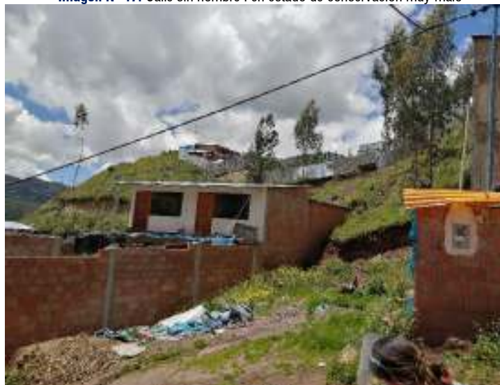
Imagen N° 47: Calle sin nombre I en estado de conservación muy malo
