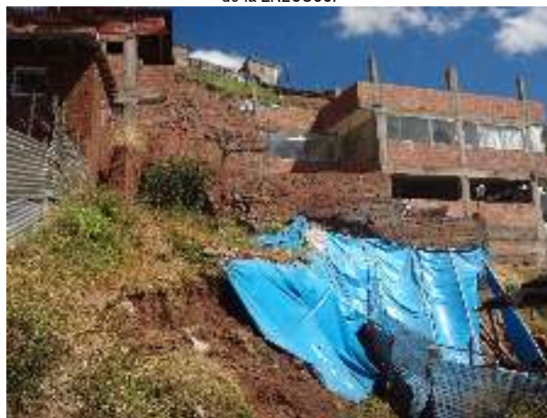
Imagen N° 20: Viviendas en laderas inestables muy susceptibles a deslizamientos, en el ámbito de estudio de la ZRECU06.
