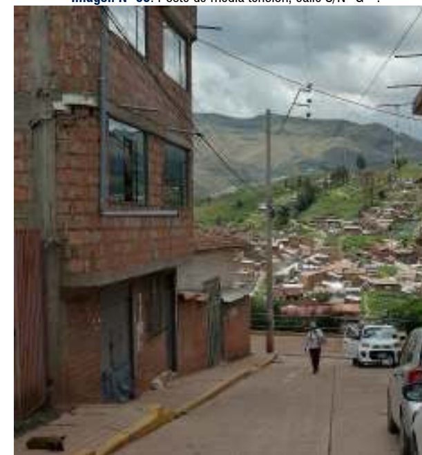
Imagen N° 69: Poste de media tensión, calle S/N "G" .
