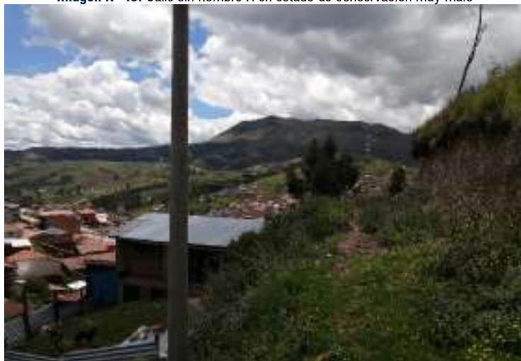
Imagen N° 48: Calle sin nombre H en estado de conservación muy malo
