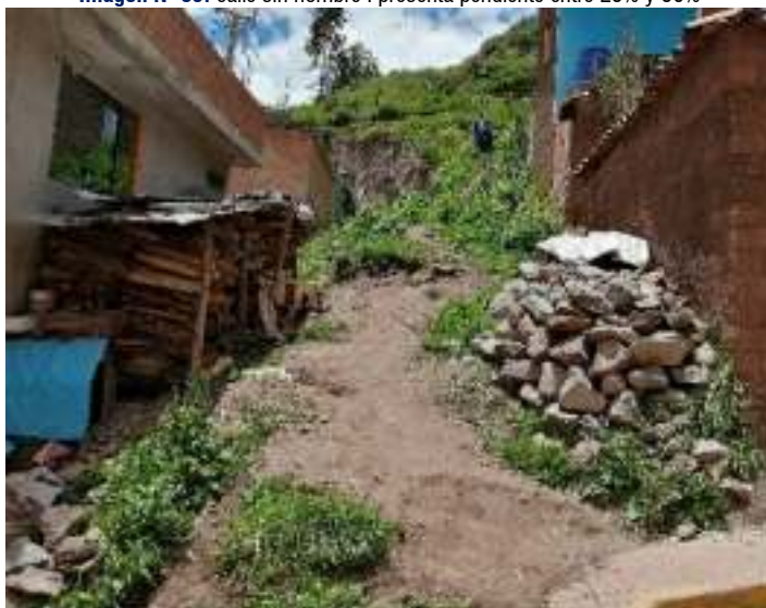
Imagen N° 39: calle sin nombre I presenta pendiente entre 25% y 50%
