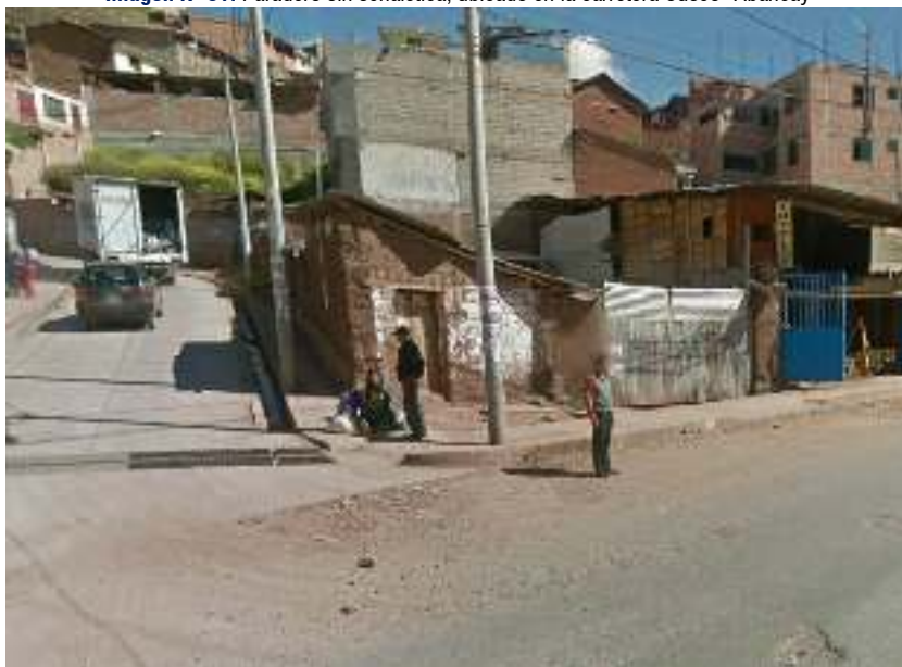
Imagen N° 51: Paradero sin señalética, ubicado en la carretera Cusco- Abancay
