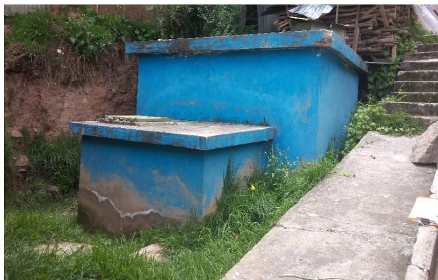
Imagen N° 48: Tanque de captación del manantial identificado en el ámbito de estudio. Fuente: Equipo técnico PM41ZRE.
