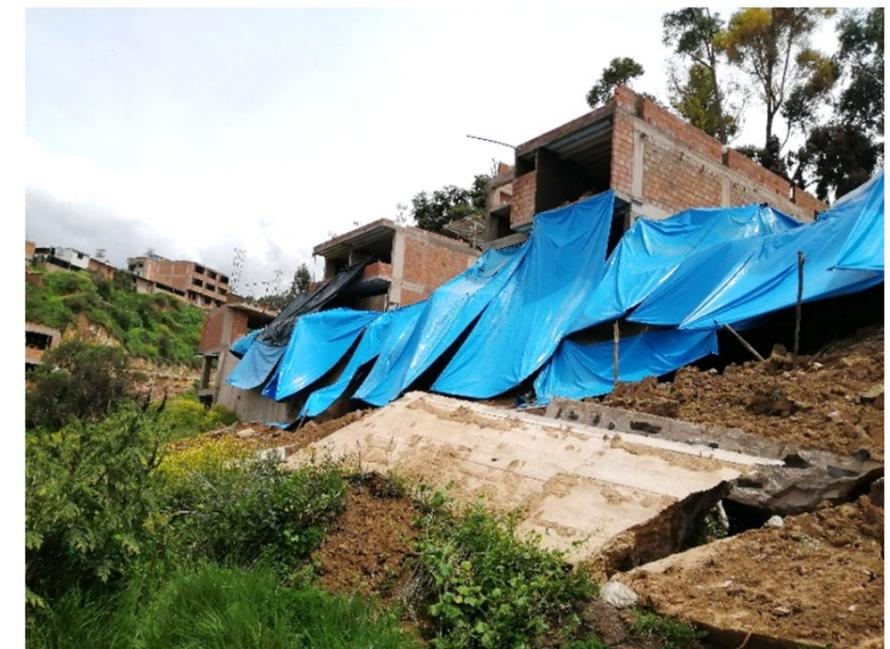
Imagen N° 32: Elemento expuesto de muro de contención colapsado en zona de peligro muy alto por presencia de depósitos de relleno no consolidado. Fuente: Equipo técnico PM41ZRE.
