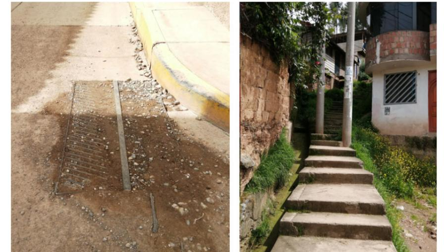
Imagen N° 68: Sumidero obstruido por falta de mantenimiento en calle Rumiñan esquina con calle Rosario Oliverra – A la derecha se ubica un canal pluvial colector descubierto. Fuente: Equipo técnico PM41ZRE.
