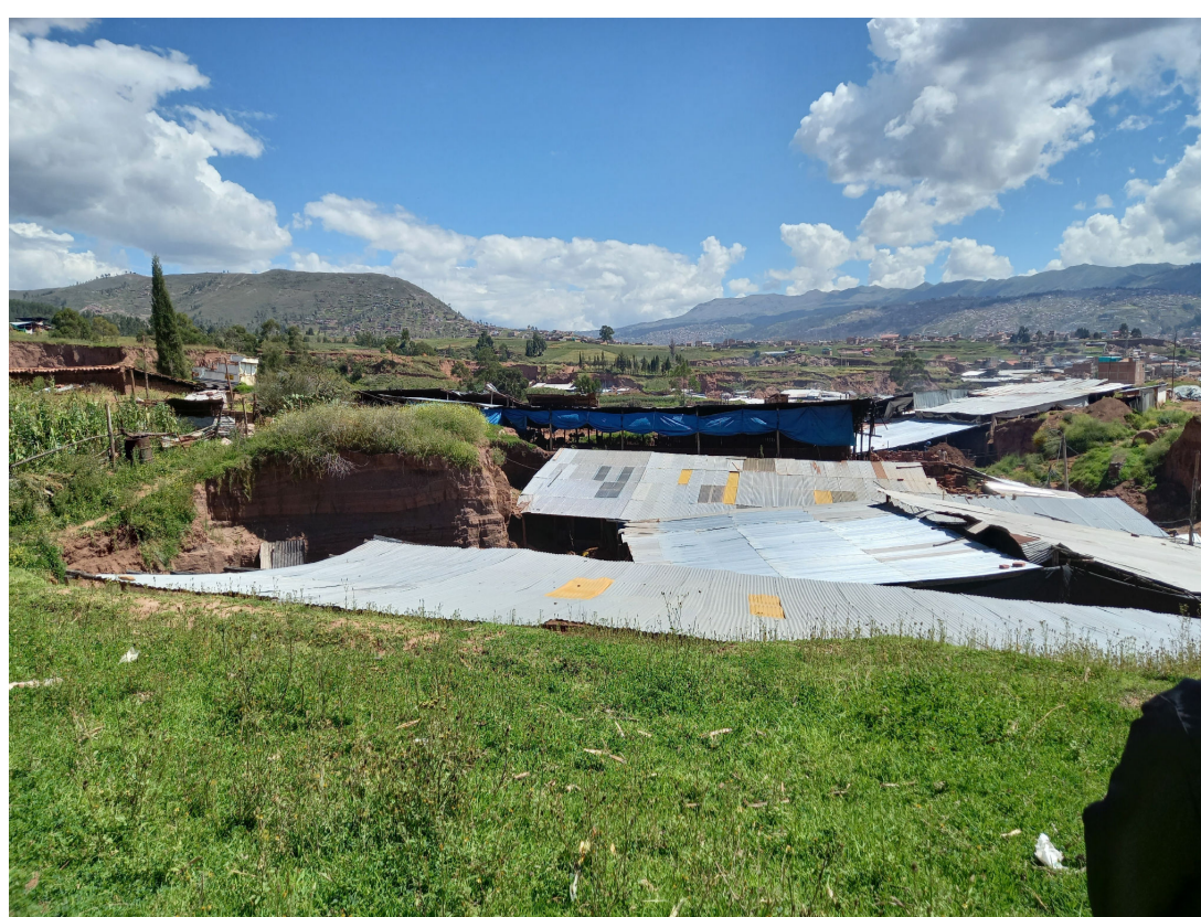
Foto 01: Vista de unidades productoras que están ubicadas cerca a un talud.
