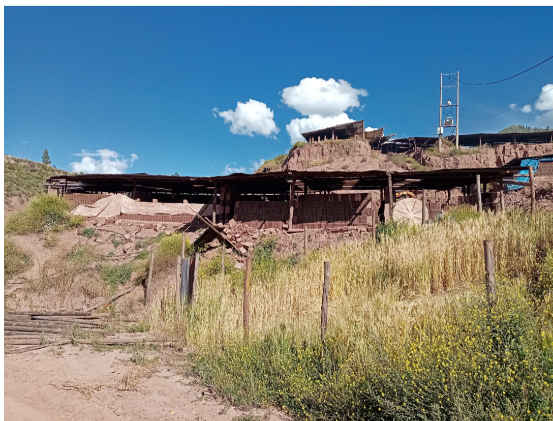
Foto 05: Vista de unidades productoras que se encuentran al pie del talud y otras unidades productoras que se encuentran en la corona del talud.
