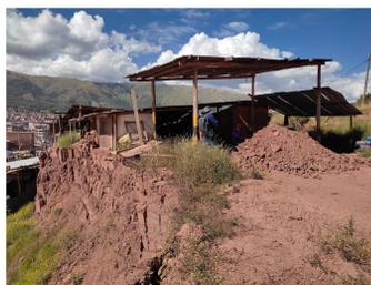
Foto 03: Unidad productiva asentada al borde del talud con presencia de grietas - Comunidad Susco Aucaylla
