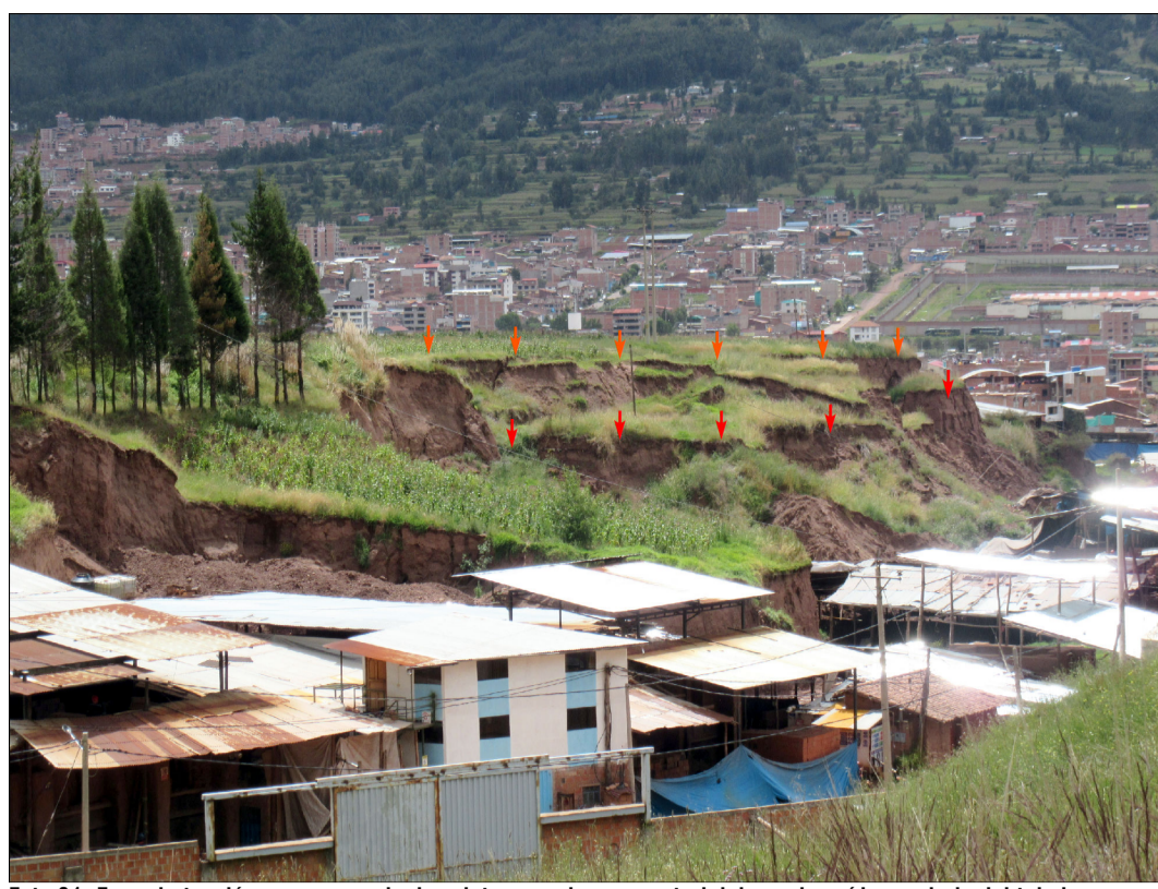
Foto 01. Zona de tensión con presencia de grietas, se observa material de suelo caído en el pie del talud.
