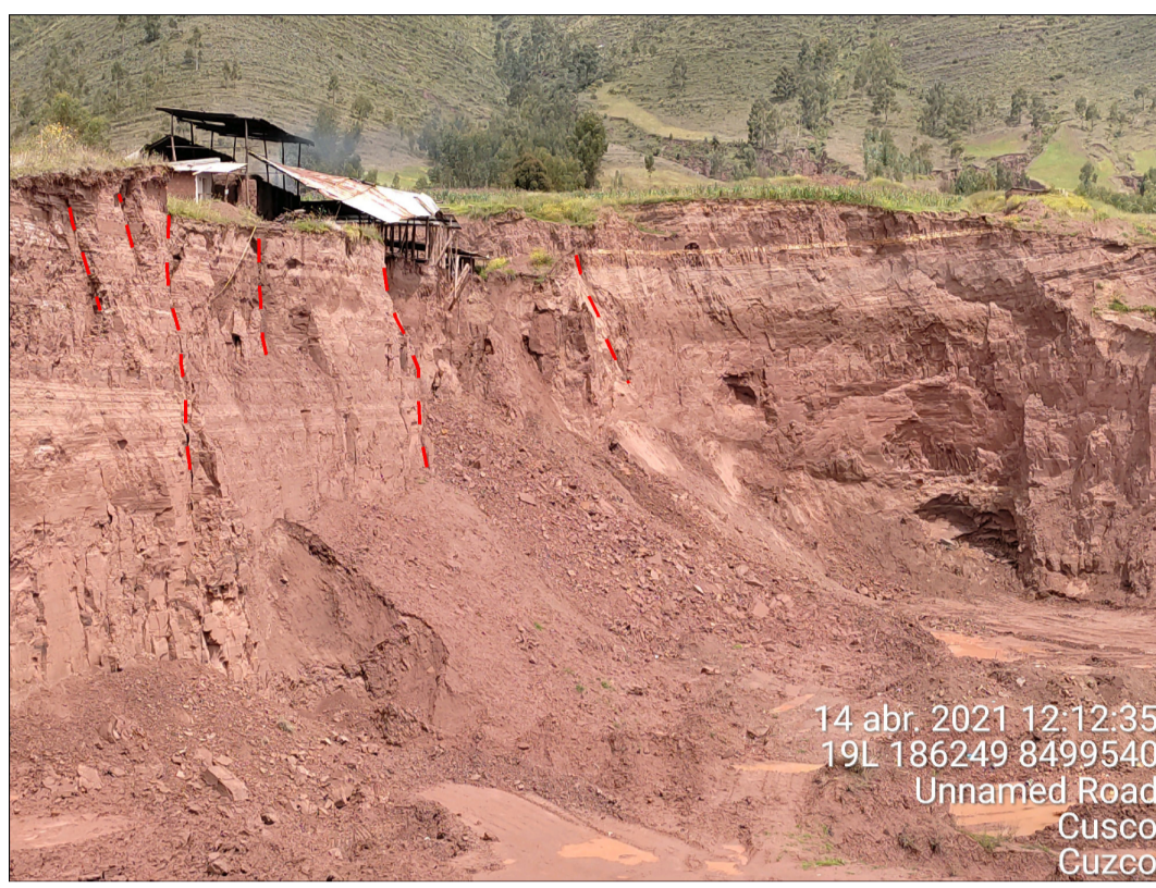
Foto 02. Talud con pendiente mayor a 37°, corte de material sin asentamiento técnico presencia de grietas, material de suelo caído en el pie del talud.
