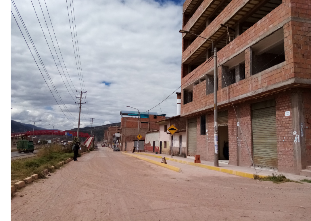
Foto 02: Lotes en proceso de construcción - A.P.V. Nueva Horizonte
