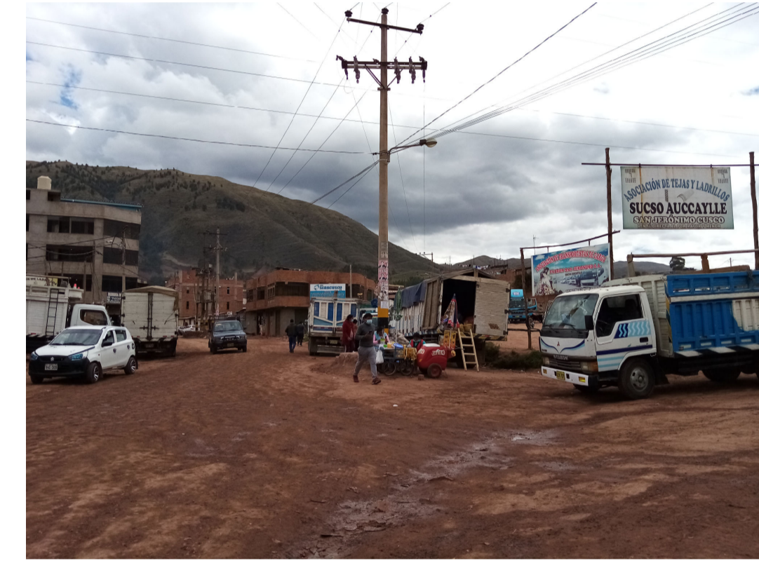
Foto 04: Pista de alumbrado público - Sector Aucaylla
