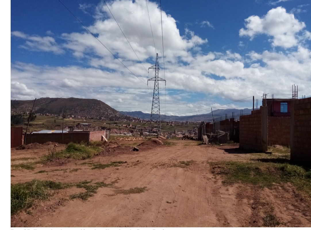
Foto 05: Torre de alta tensión - Los Nogales de Petro Peru
