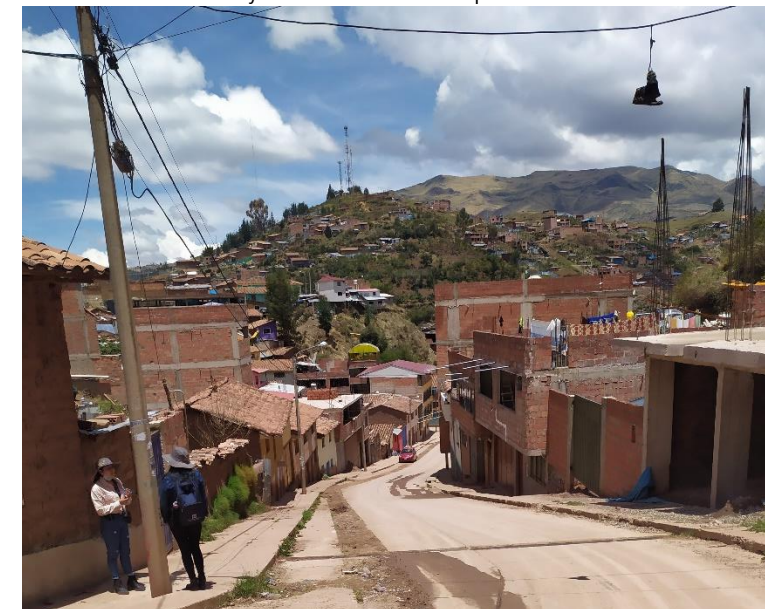
Imagen N° 70: Poste de alumbrado público instalado en la mitad de la acera, disminuyendo y obstaculizando el tránsito peatonal
