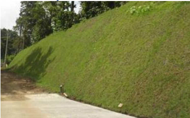
Imagen N° 85: Geomanta de control erosional
