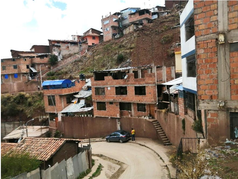
Imagen N° 55: Obstrucción de vereda en calle S/N 02 para estacionamiento informal
