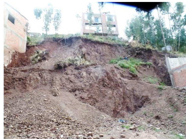
Imagen N° 4: Vista de corte de Talud donde se observa el basamento rocoso conformado por areniscas cuarzo feldespáticas y lutitas de la formación Kayra.
