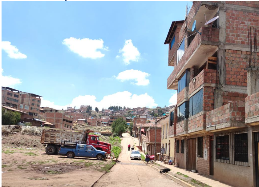
Imagen N° 55: Estacionamiento de vehículo en Av. Retamales
