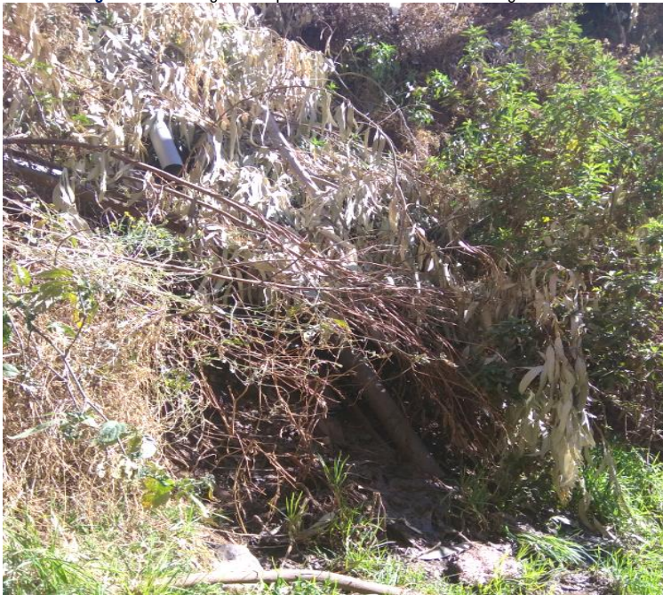
Imagen N° 47: Fotografía de punto crítico de vertimiento de aguas servidas
