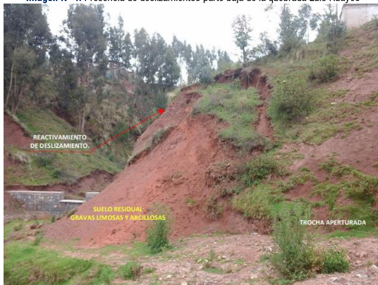
Imagen N° 4: Presencia de deslizamientos parte baja de la quebrada Luis Huayco
